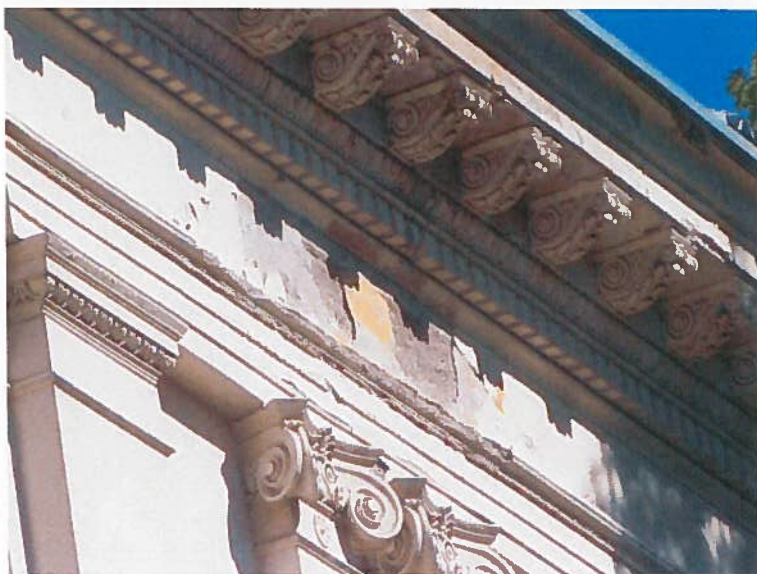
Slika 21: Lokalne poškodbe v območju fasadnih vencev, luščenje opleska, razpadanje ometa
