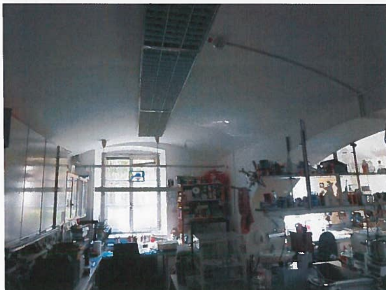
Slika 8: Masivni obokani stropi v pritličnih prostorih
