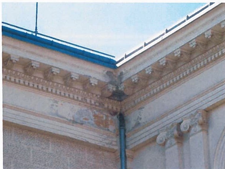
Slika 24: Lokalne poškodbe v območju napušča, luščenje opleska, razpadanje ometa – posledica zamakanja žlebov oziroma vertikalnih cevi za odvod meteorne vode
