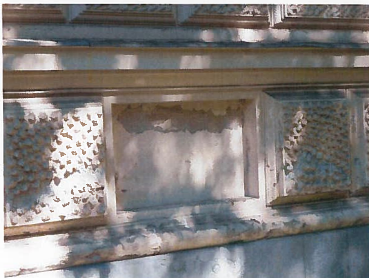
Slika 20: Lokalne poškodbe na profilaciji fasade nad coklom, luščenje opleska, razpadanje ometa
