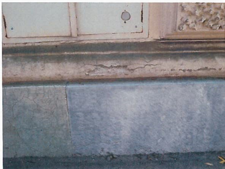
Slika 18: Lokalne poškodbe na profilaciji fasade nad coklom
