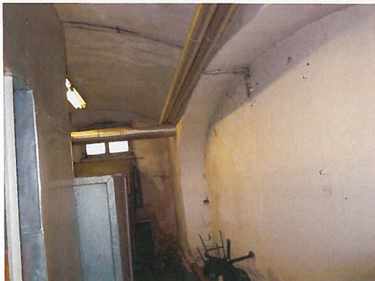
Slika 11: Poškodbe ometa zaradi prekomerne vlage v kleti
