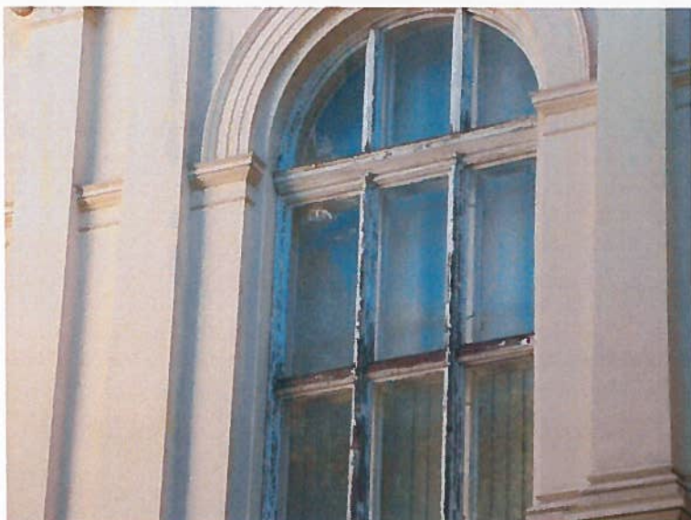
Slika 19: Dotrajana zaščita lesenih elementov okenskih okvirjev
