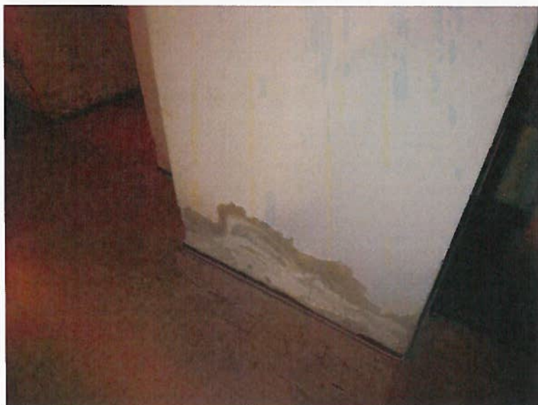
Slika 13: Poškodbe ometa zaradi prekomerne vlage v zidovih pritličja
