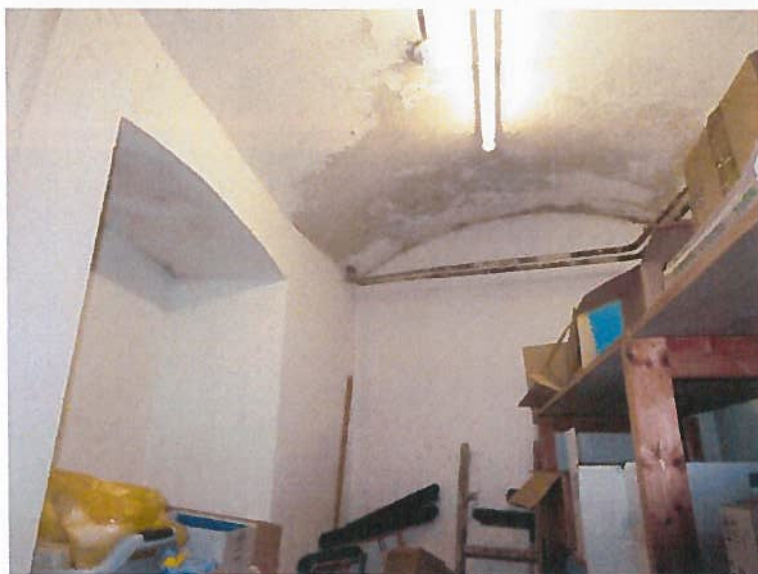
Slika 12: Poškodbe ometa zaradi prekomerne vlage v kleti
