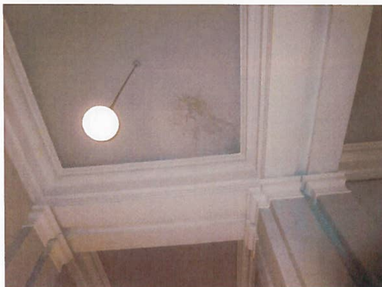
Slika 15: Sledovi zamakanja na stropni konstrukciji nadstropja
