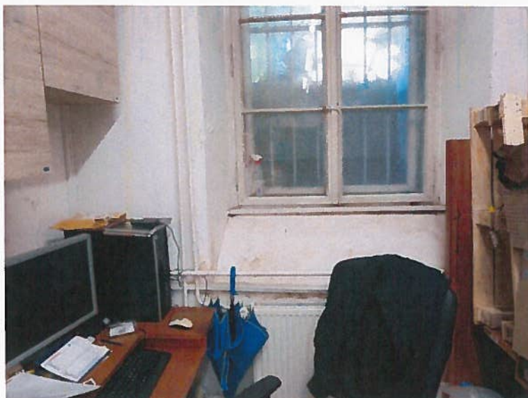
Slika 10: Poškodbe ometa zaradi prekomerne vlage – najverjetneje zamakanje ob okenski odprtini
