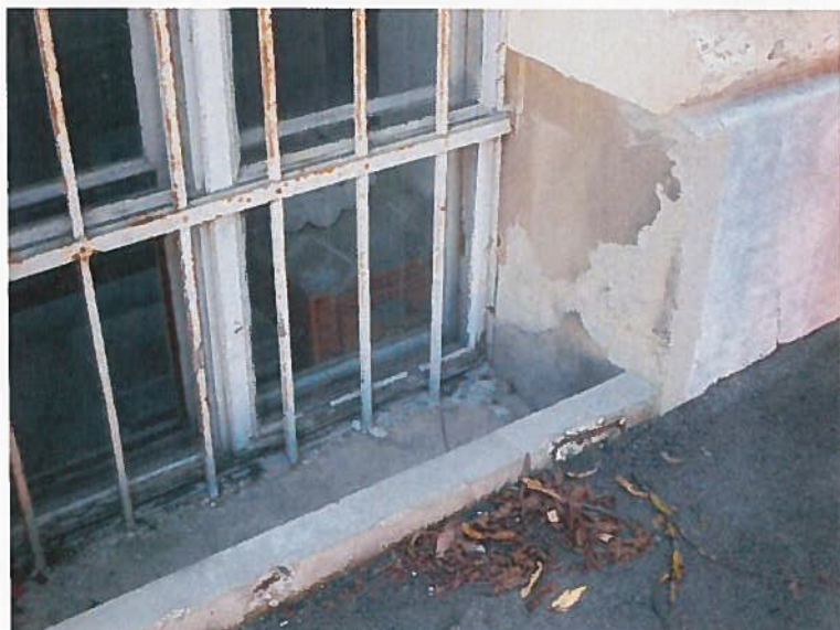
Slika 17: Poškodbe ometa, luščenje opleska, odpadanje krovne sloja betona, korozija armature
